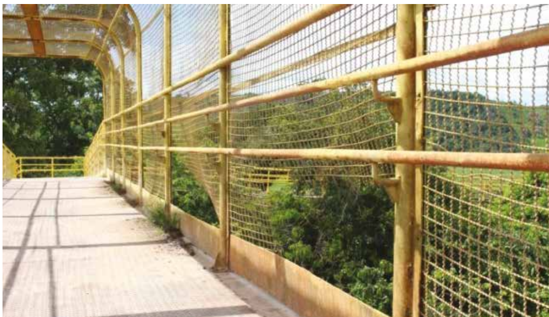
Imagem 81: Passarela localizada em Vila Concórdia. Grade de proteção da passarela em precárias condições.
