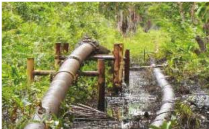
Imagem 65: Dutos em péssimas condições, que demonstram como a atividade petrolífera é exercida.
