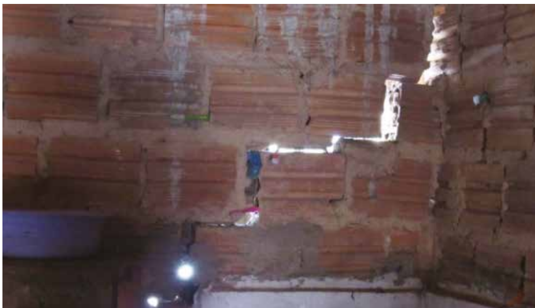
Imagem 79: Figuras 4 e 5 – rachaduras em moradia localizada no entorno da EFC, ocorridas após o início das obras de duplicação
