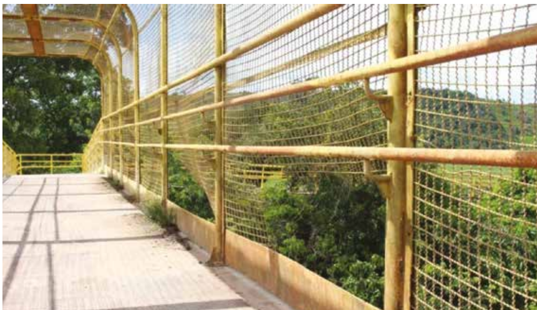
Imagen 81: Puente ubicado en Vila Concórdia. Rejilla de protección del puente en condiciones precarias.
