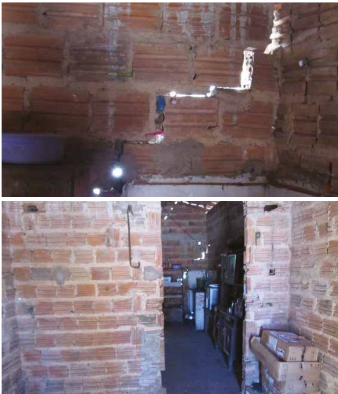
Imagen 79: Grietas en una de las viviendas ubicada en el entorno de la EFC, ocurridas después del inicio de las obras de duplicación
